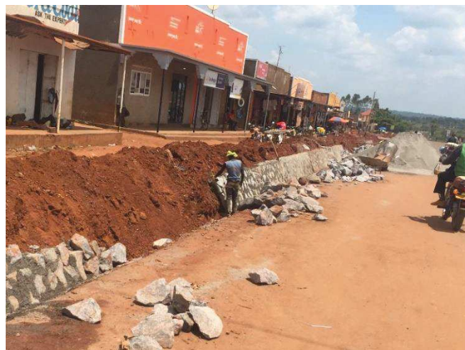
【道が整備され、水路が設けられているところ】
